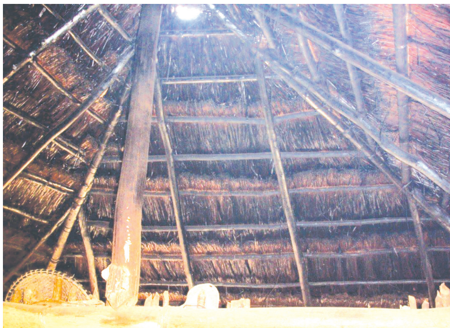
Figura 5: Estrutura do telhado da casa quilombola em São João
