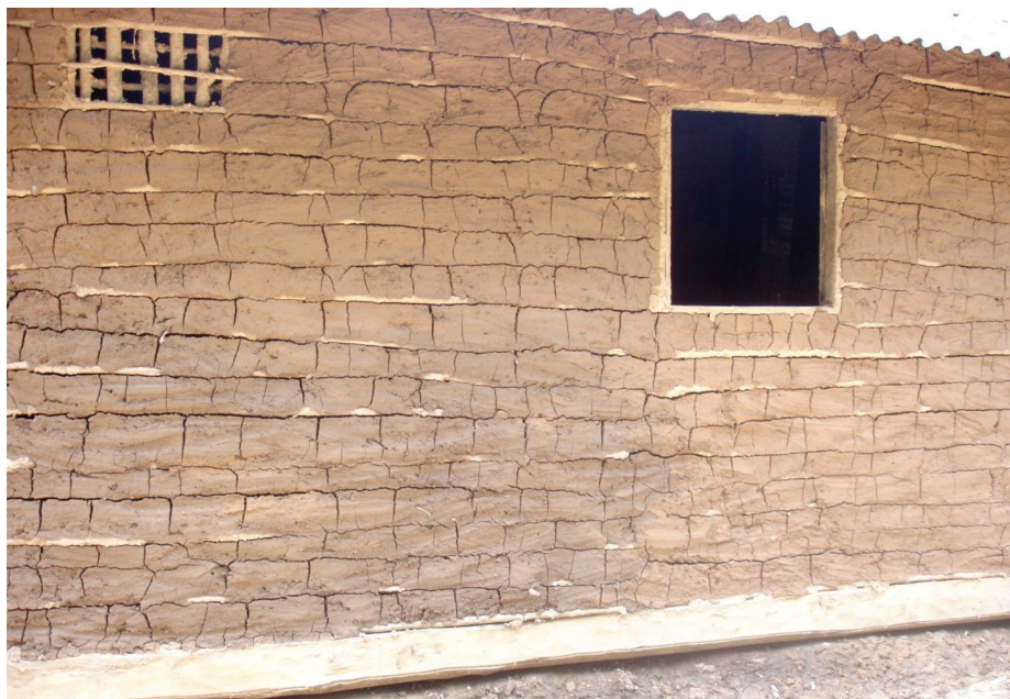
Figura 6: Estrutura da parede da casa quilombola em São João
