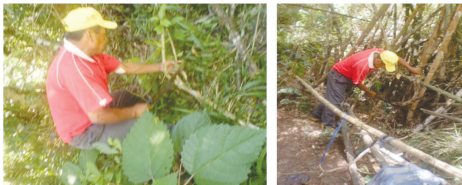
Figura 5: Retirada do taquaruçu e do cipó guambé
